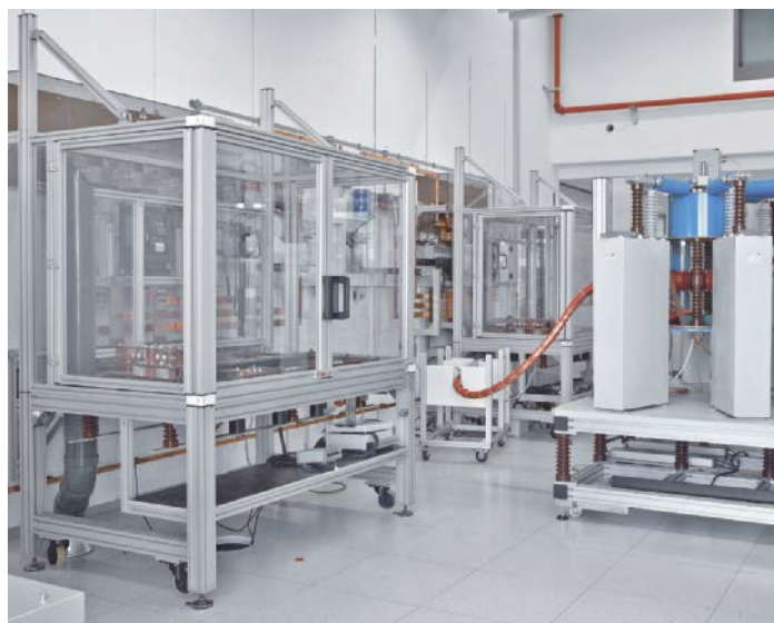
Ilustr. 25: Stanowiska kontrolne systemu wysokoprądowego
