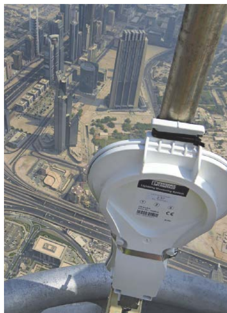
Ilustr. 35: System LM-S w wieżowcu Burdż Chalifa
