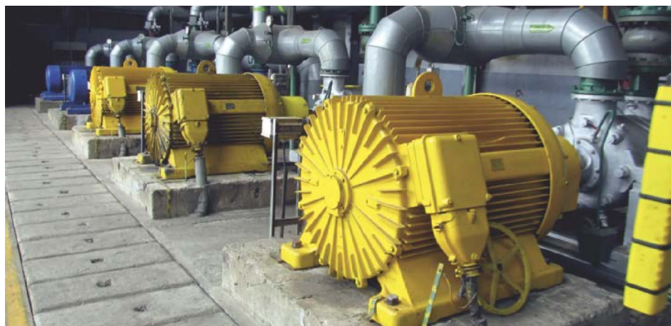
Ilustr. 2: Silniki elektryczne o dużej mocy indukują przepięcia na skutek wysokich prądów załączania
