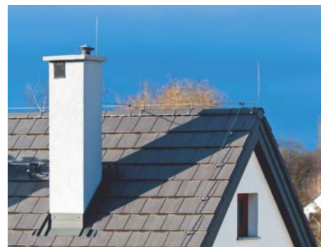
Ilustr. 15 Zewnętrzna ochrona odgromowa na przykładzie domu jednorodzinnego
