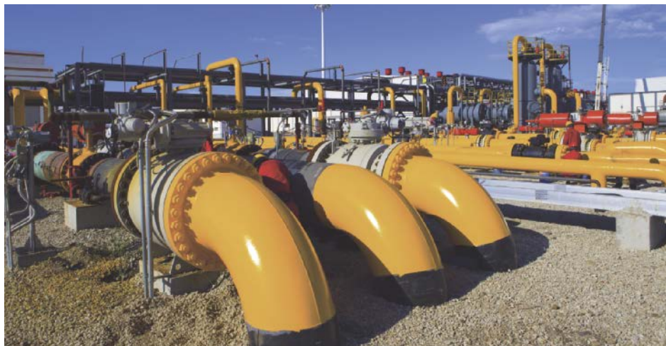
Ilustr. 96: Typowe zastosowanie: stacja tłoczenia gazu
