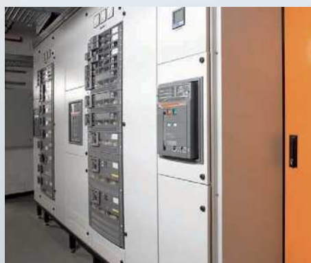
Zasilanie niskiego napięcia
