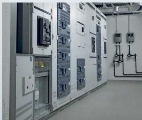
Zasilanie niskiego napięcia
