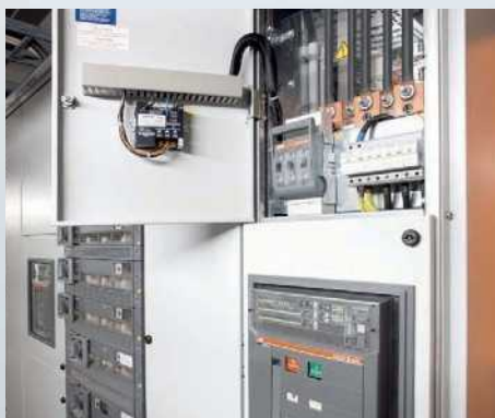
Zasilanie niskiego napięcia
